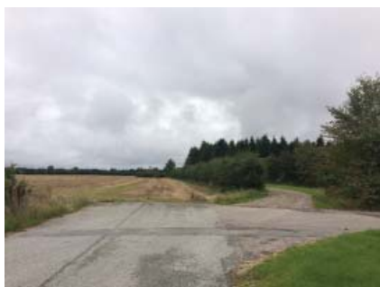
Overgangen fra Energivej til grusvejen mod Systemvej. Grusvejen vil på sigt kunne opgraderes så den kan fungere som adgangsvej til den del af Energivej, hvor det eksisterende varmekværk ligger idag.
