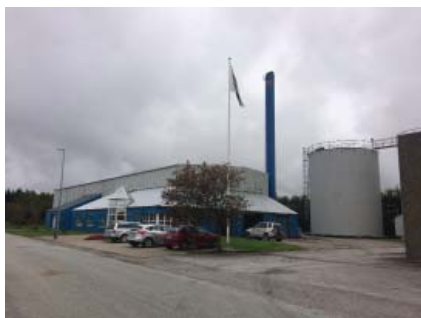
Det eksisterende varmekværk på Energivej.
