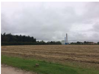
Lokalplanområdet set fra Sdr. Fælledvej mod det eksisterende varmekværk
